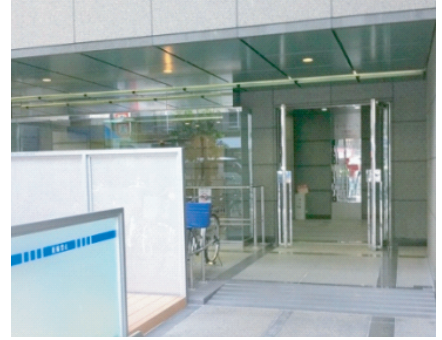
正面エントランス
